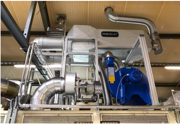
Druckindustrie - Blechdrucken Leistung: 350 Nm 3 /h
